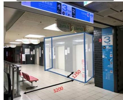
No1,2号機 仕上げ3月26日～3月28日 (予定)
